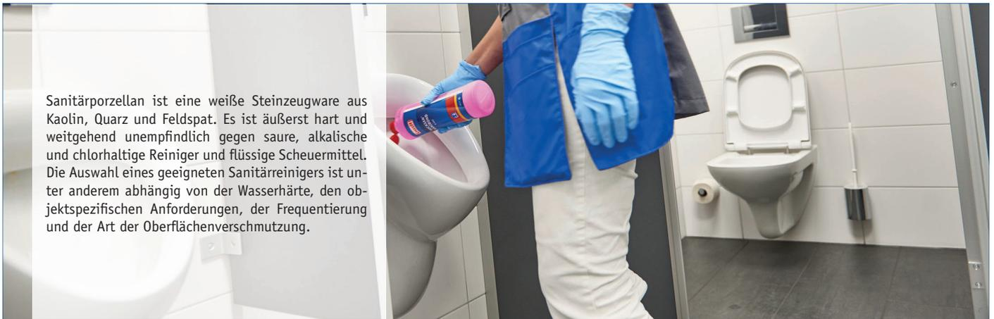
Sanitärporzellan ist eine weiße Steinzeugware aus Kaolin, Quarz und Feldspat. Es ist äußerst hart und weitgehend unempfindlich gegen saure, alkalische und chlorhaltige Reiniger und flüssige Scheuermittel. Die Auswahl eines geeigneten Sanitärreinigers ist unter anderem abhängig von der Wasserhärte, den objektspezifischen Anforderungen, der Frequentierung und der Art der Oberflächenverschmutzung.
