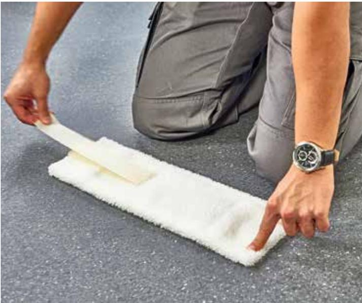
Flusen auf dem Mopp können vor der Beschichtung mit einem Klebestreifen entfernt werden.
