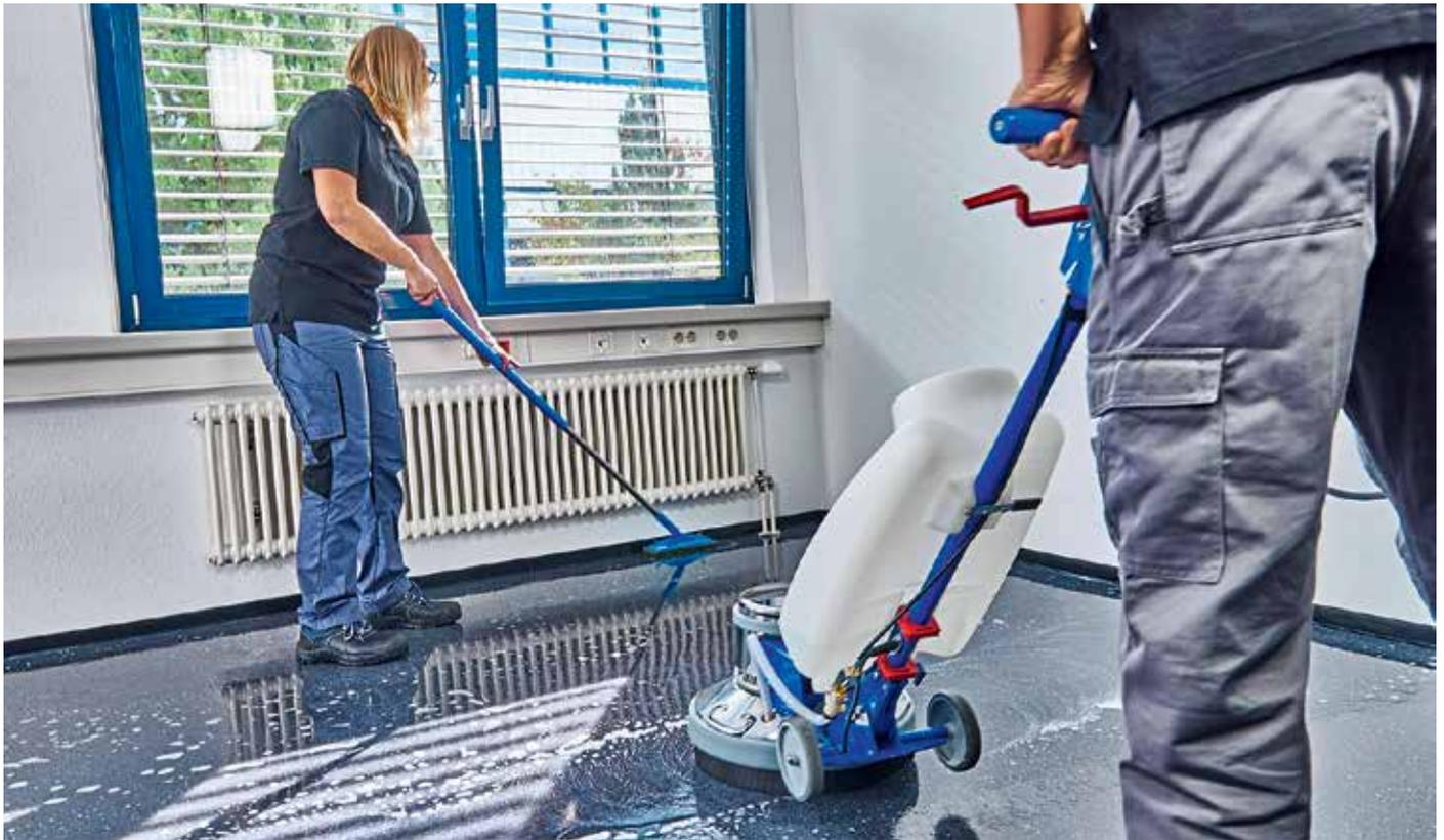
Bei der Grundreinigung wird abschnittsweise gearbeitet, Randbereiche werden manuell gereinigt.
