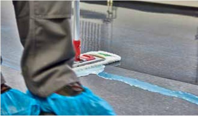
Nach jedem Beschichtungsauftrag ist auf ausreichende Trocknung zu achten.
