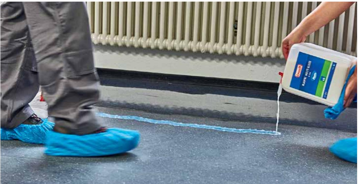
Gleichmäßiges Vorlegen des Beschichtungsmittels erleichtert ein Auslaufhahn am Kanister.
